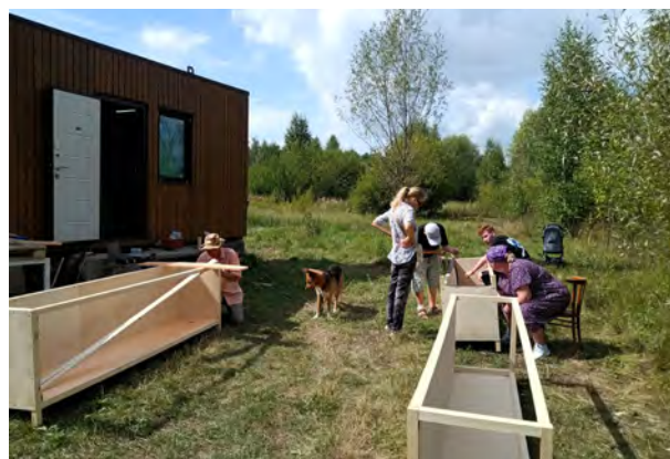
Сборка каркасов климатических камер в питомнике редких трав. Камеры утеплили, поскольку вагончик (слева) не отапливается, а рассаду начинаем готовить уже в конце февраля. Фото А.В. Бортякова
